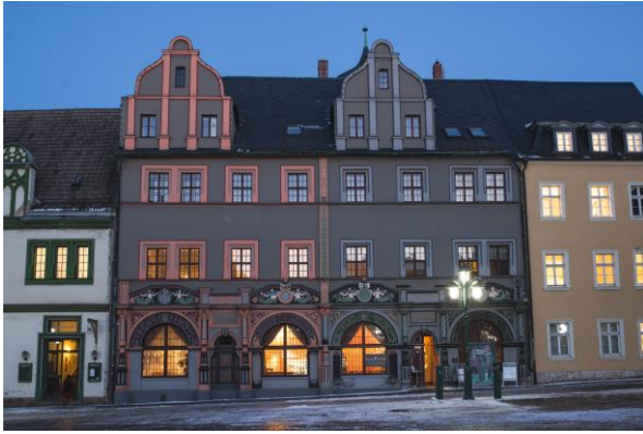
Abbildung 11: Beispiel für eine detailreichere Fassade Motiv: Cranachhaus Weimar Quelle: Foto zur Verfügung gestellt von device+context
