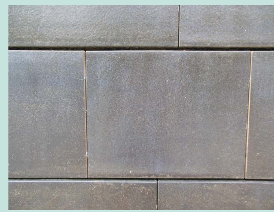
Abb. 6 - Ansicht Fassadenbekleidung aus Keramik
