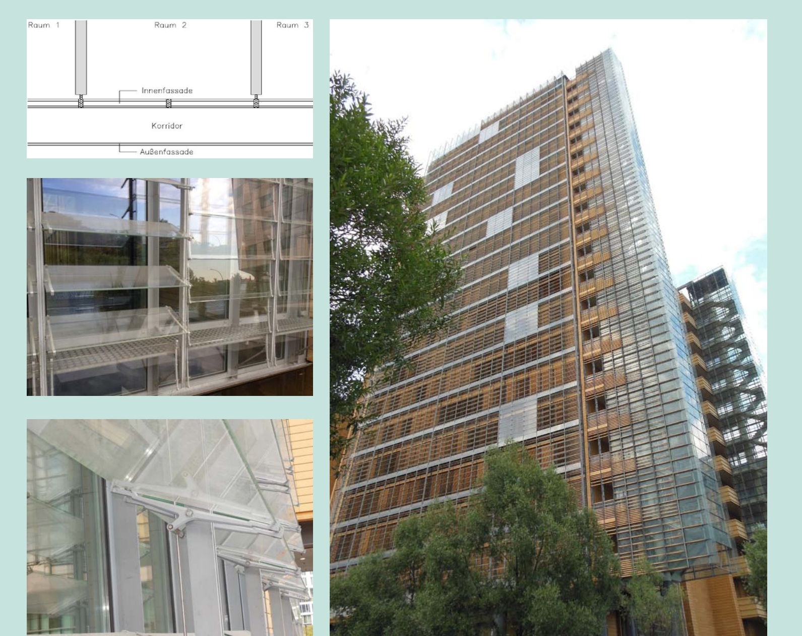
Abb. 17 - Korridorfassade der debis Hauptverwaltung
