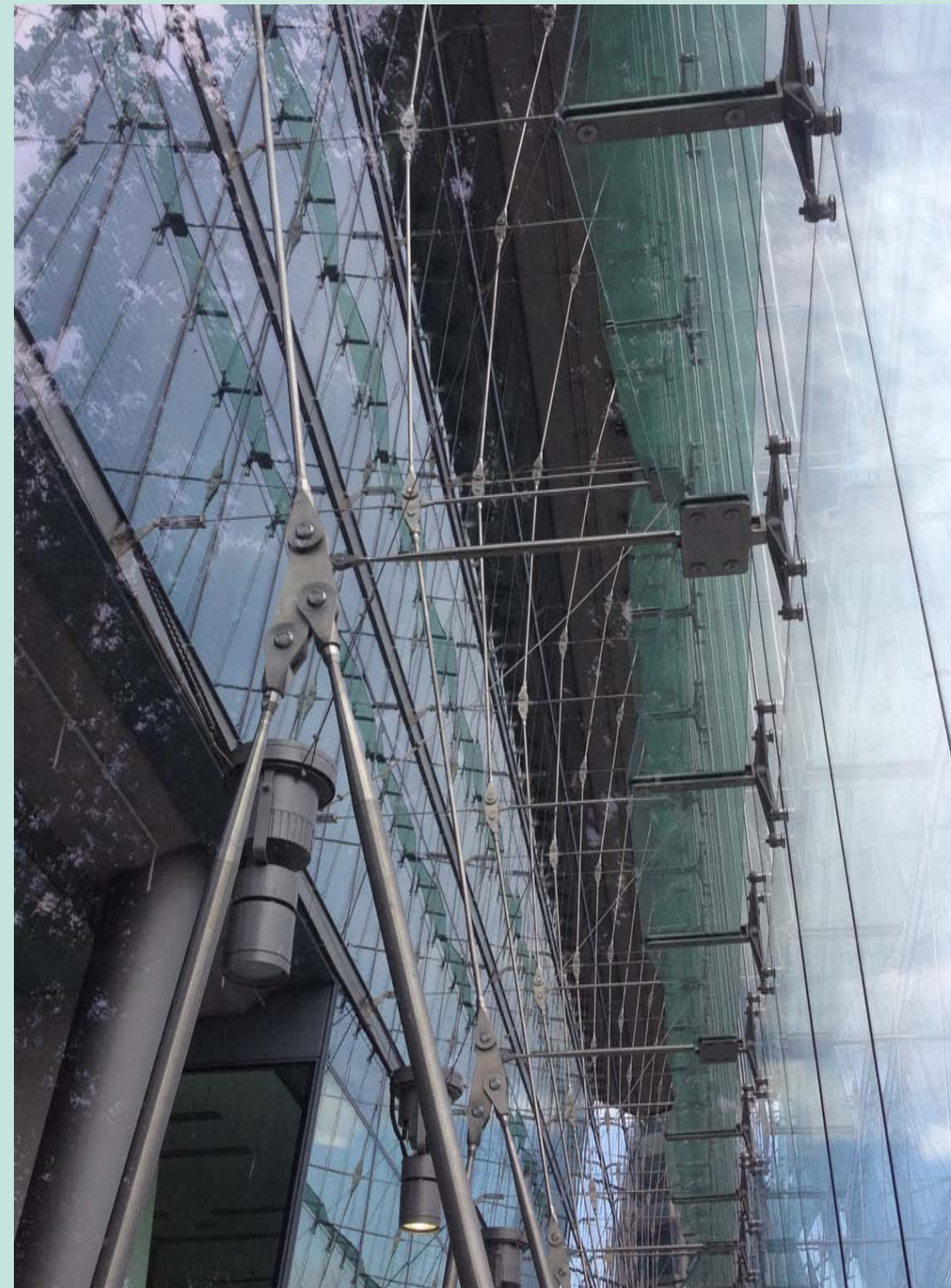
Abb. 9 - Hinterspannung einer Glasfassade
