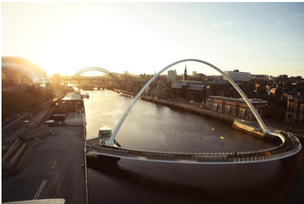
Millenium Bridge – Photo by Juho Jääskeläinen
