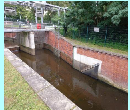
Abbildung 1: Rechenanlage und Schlauchwehr
