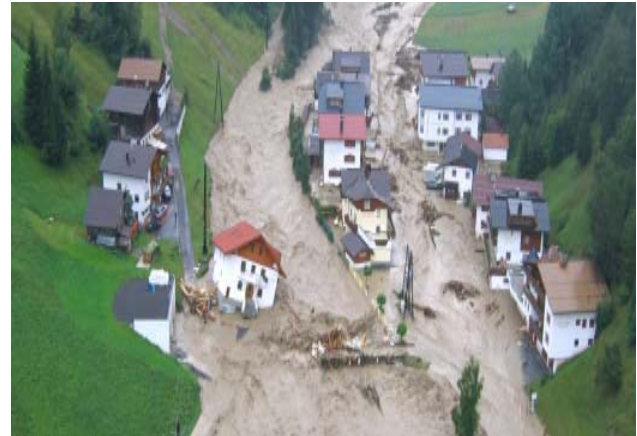
Abbildung 1: Gebäudeschäden durch Wassereinwirkung
