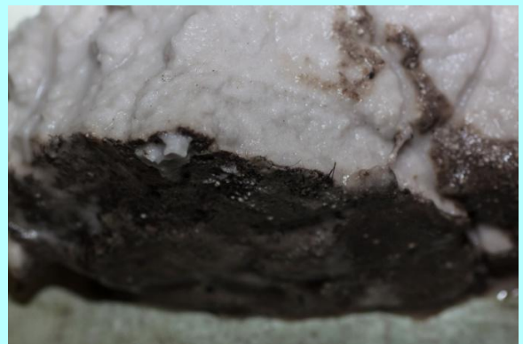
1: Abdichtungshorizont unter der Perlitdeckschicht
